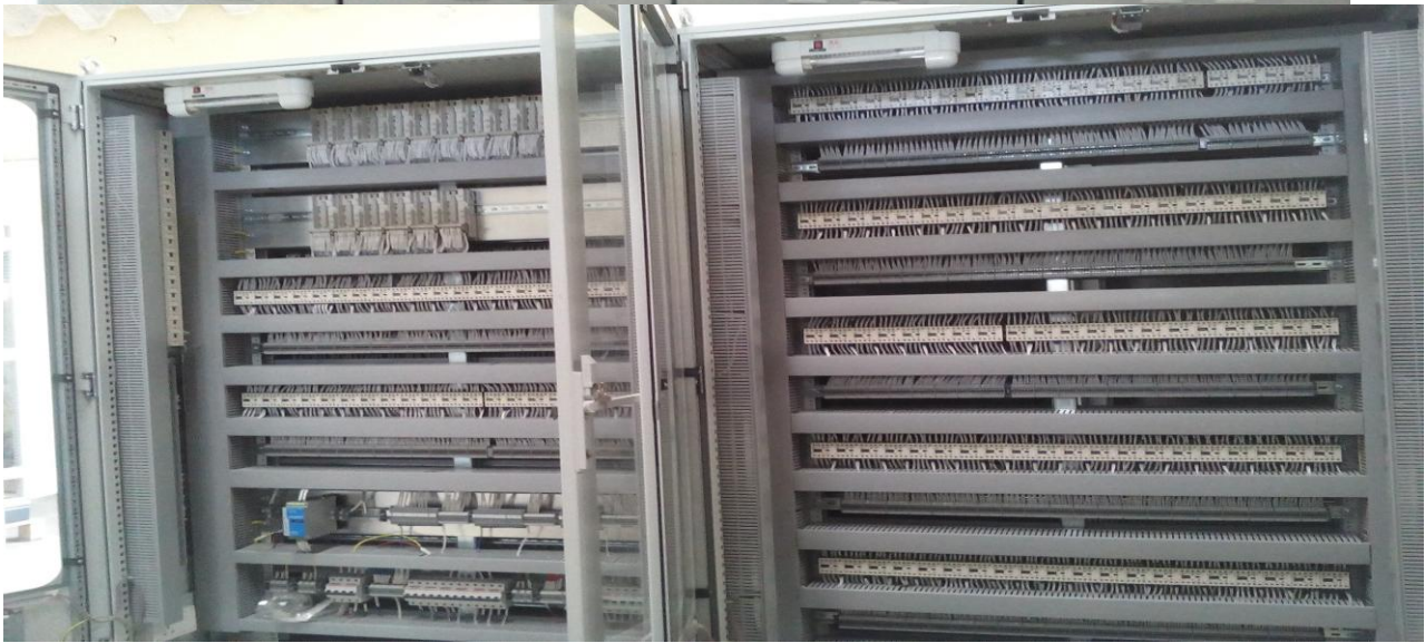
1MW SOLAR PANEL :
